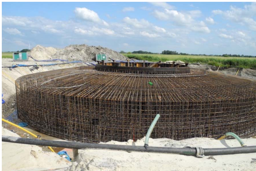
2. ábra. Egy szélerőművi torony vasbeton alapjának vasalása
