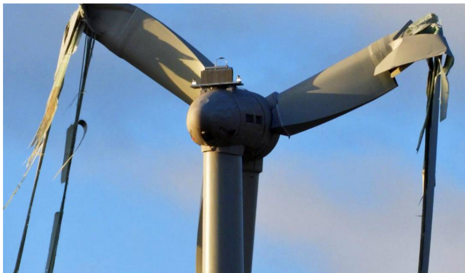
Bild 1. Instant Schrott: Massiver Schaden an einer damals nagelneuen Enercon-WEA in Borchsen (Foto: Gudrun Ponta)
