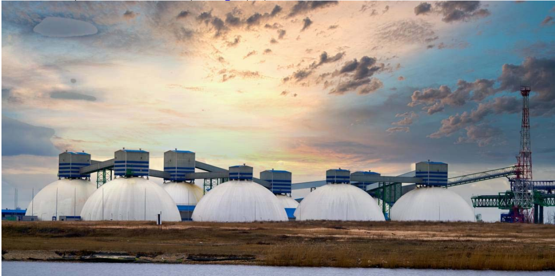
Natural Gas Storage USA, Shutterstock - Földgáztárolók
