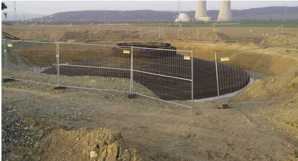
A 3,5 MW-os Vestas szélérőművi torony alapozása, háttérben a Grohnde Atomerőművel.
